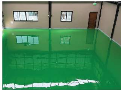
บริการเคลือบพื้นอุตสาหกรรม Flooring System (Epoxy, PU)
