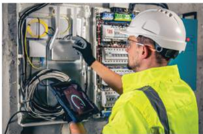
ติดตั้งระบบไฟฟ้า ระบบน้ำ ระบบประปา (Electrical, Air, Water Systems)
