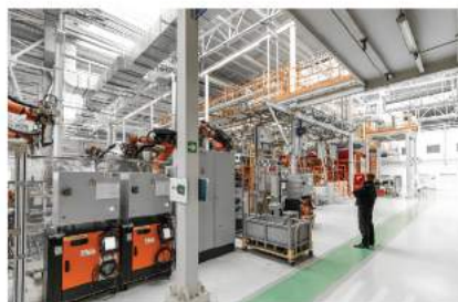
ขนย้ายเครื่องจักร ประกอบเครื่องจักร (Move & Machine Installation)
